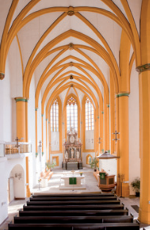
Voldoende licht: de gotische bouwstijl maakt plaats voor grote vensters mogelijk.
