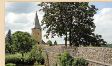
Begehbare Stadtmauer von Herbstein
