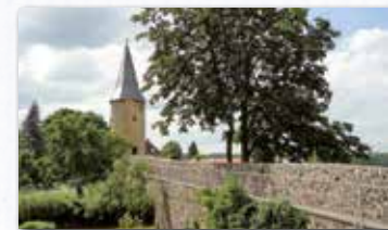
Begehbare Stadtmauer von Herbstein
